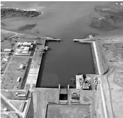
Infraestructura fluvial y marítima
